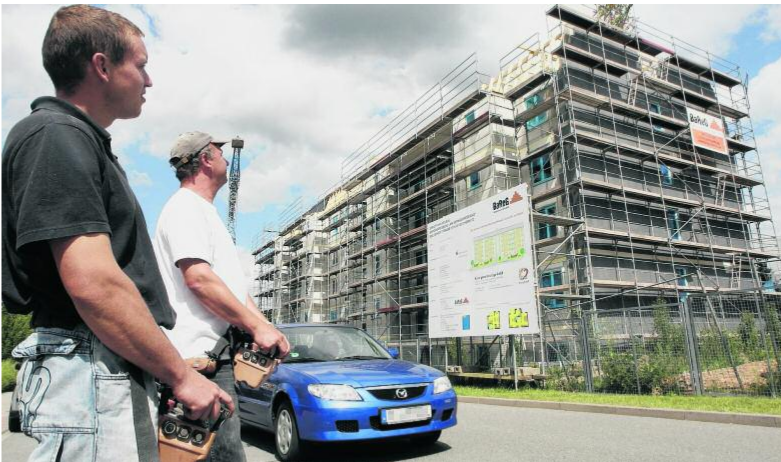
An der Eislebener Straße in Bernsdorf entsteht ein Haus mit altersgerechten Wohnungen, das noch in diesem Jahr fertig werden soll. 80 Prozent der Wohnungen sind nach Auskunft des Bauherren bereits vermietet. FOTO: ANDREAS TRUXA
