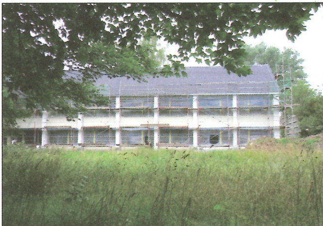
Das Frühförderzentrum im Juli 2008 im Bau ...
